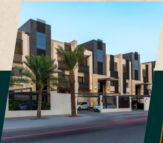
Dur Alsafarat – Riyadh 434 units
